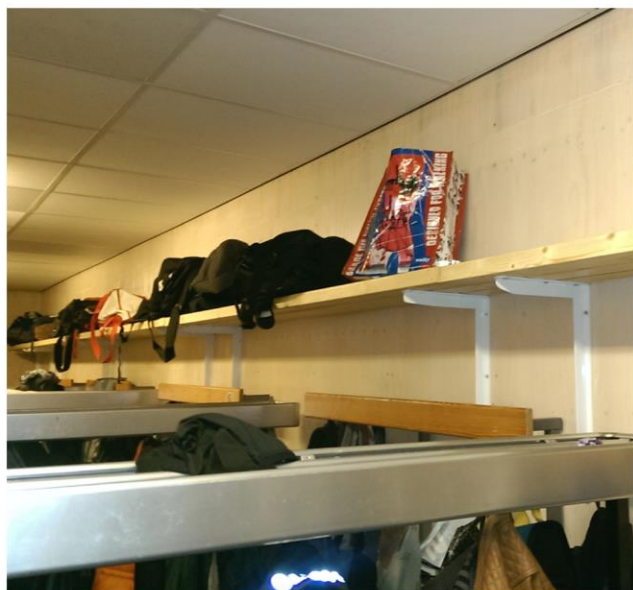
De nieuwe tassenrekken in de herenkleedkamer
